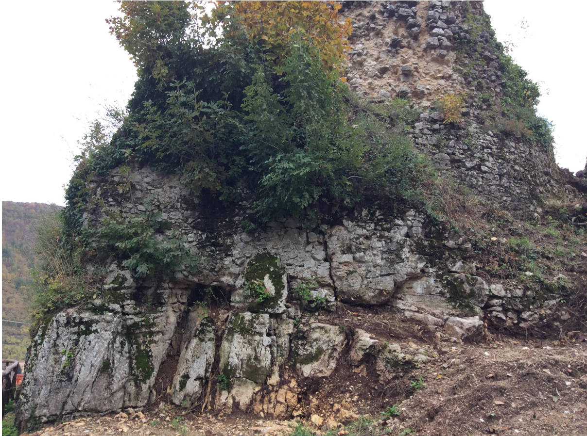
Fig.2 Il banco roccioso emergente con tracce di lavorazione della roccia ed inserimento di paramenti murari
