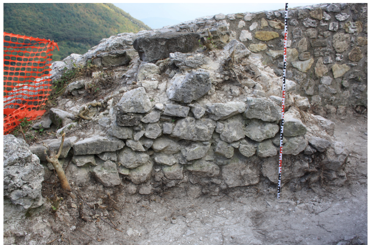
Figg.23 a-b. In alto il vano scala, in basso le spallette delle scala (USM 100)
