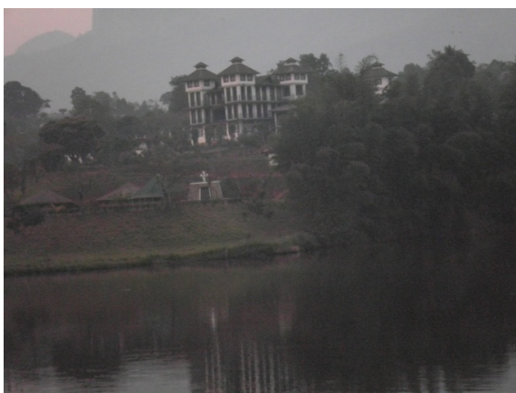
Figura 15: La casa vista dall'altra parte del lago
