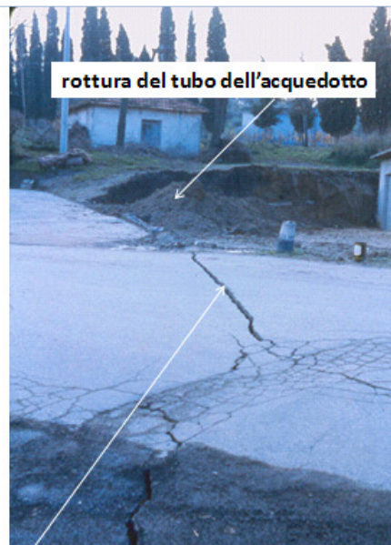
Flumeri: spostamenti verticali e rottura di manufatti
