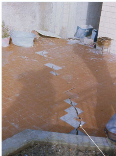
Flumeri: spostamenti verticali e rottura di manufatti
