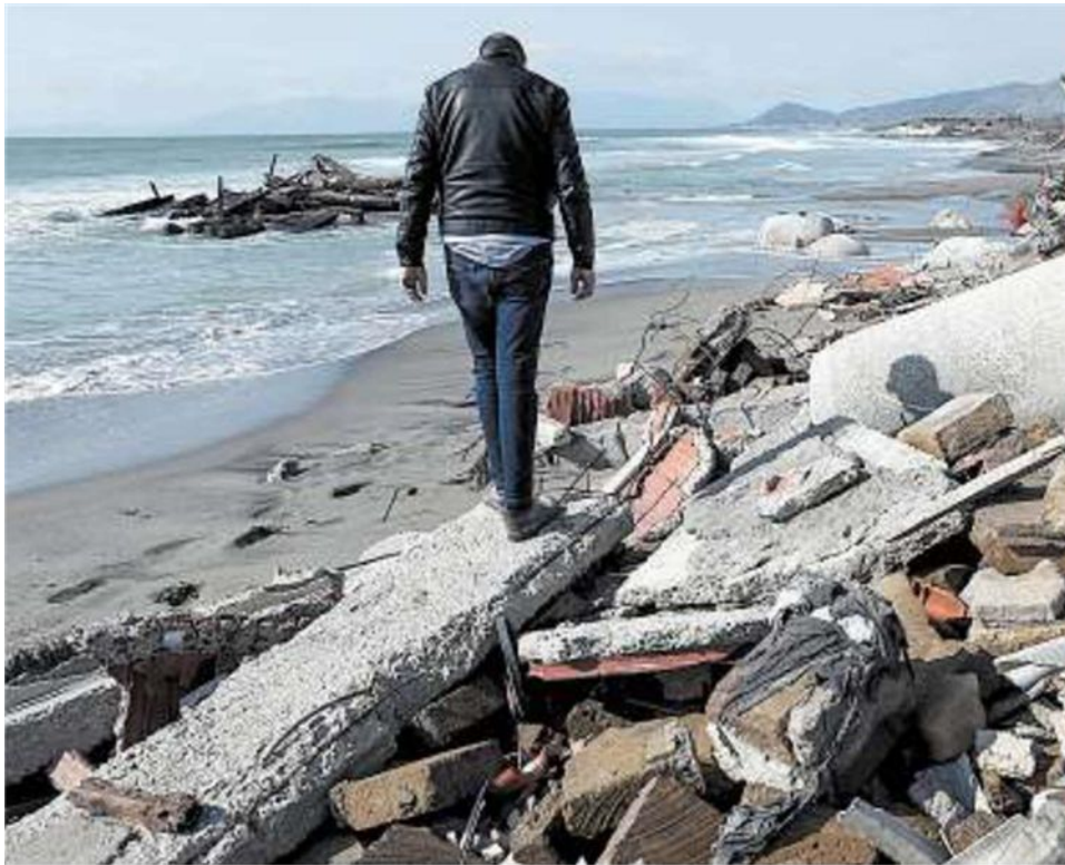
Due istantanee del degrado sulla costa del litorale casertano, a Castel Volturno
