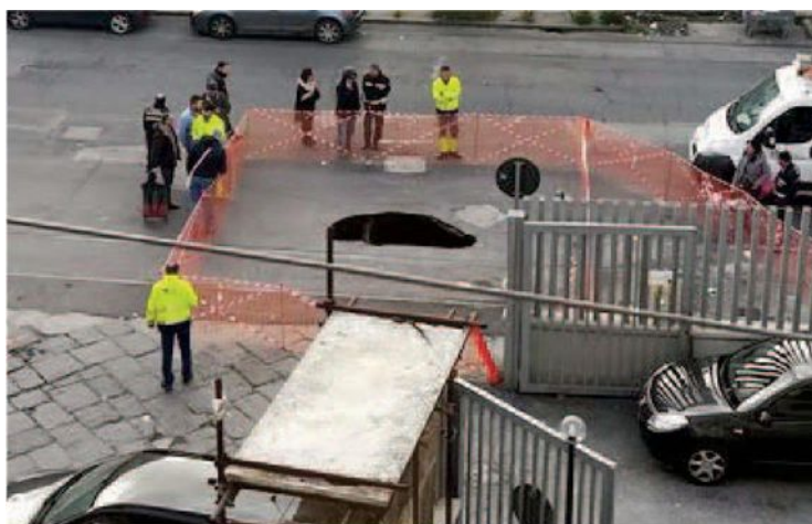
● La voragine in via Giulio Cesare a Fuorigrotta
